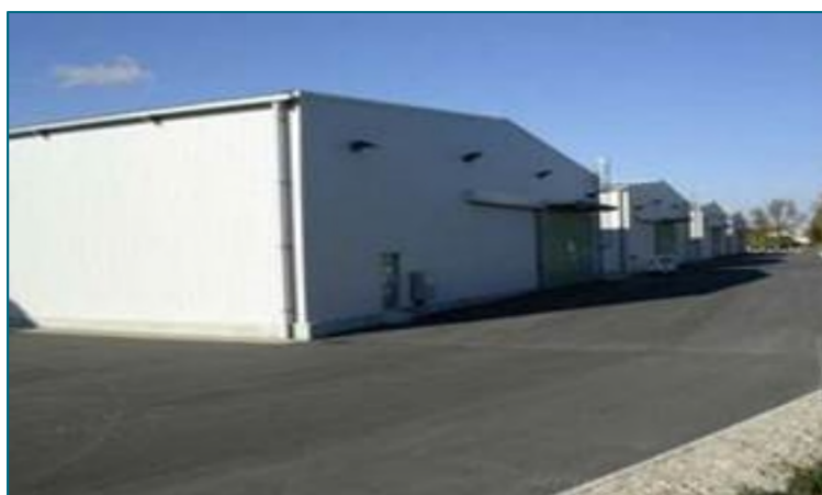
Figure 11 : Vue des bâtiments du parc P35 (INB 179)
