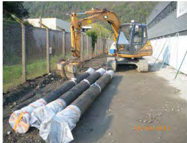
Retrait tuyauteries rejet Isère
