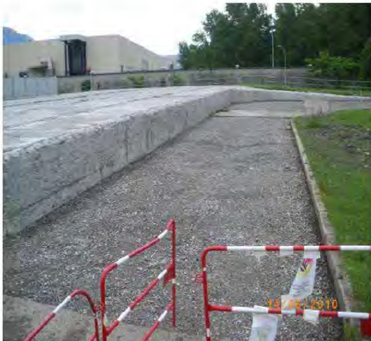
Bitumes devant bâtiment L
