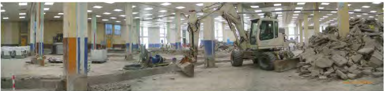
Assainissement de la dalle de sol et des galeries du Bâtiment A
