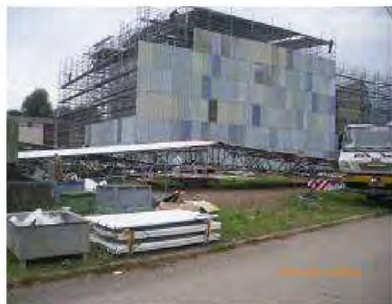
SAS du bâtiment F
