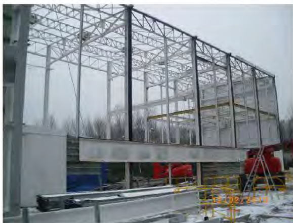
Démontage du bâtiment G
